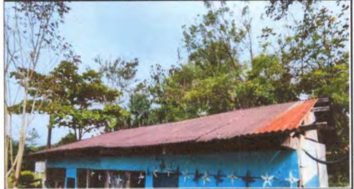
Foto 2: Se observa el deterioro de la lamina del aula de tercero y cuarto primaria
