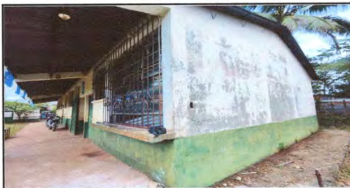
Foto 5: Se observa el deterioro de la estructura portante, desprendimiento pintura en las paredes
