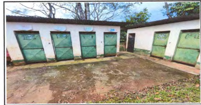
Foto 6: Se observa el deterioro de pintura en las paredes y puertas de los baños
